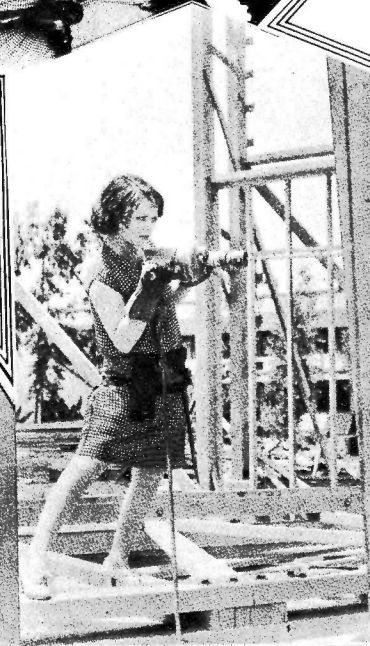
SALLY STARR se está construyendo una nueva casa en Hollywood, y para dar ejemplo a los obreros, toma la barrena y la maneja con la facilidad que ustedes pueden ver. (Foto Wm. Grimes).
